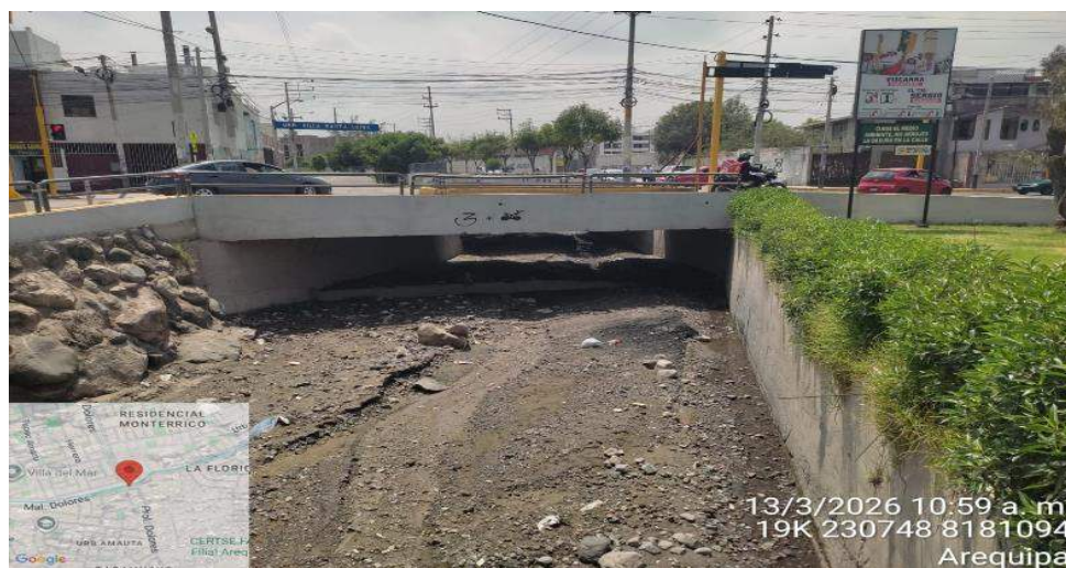
IMAGEN 02: SE OBSERVA LA COLMATACION DE LA QUEBRADA S/N, EN LA MARGEN DERECHA REQUIERE DE MURO DE CONCRETO ARMADO PARA EMPALMAR AGUAS ABAJO CON LA CONTINUACION DEL MURO DE CONCRETO ARMADO
