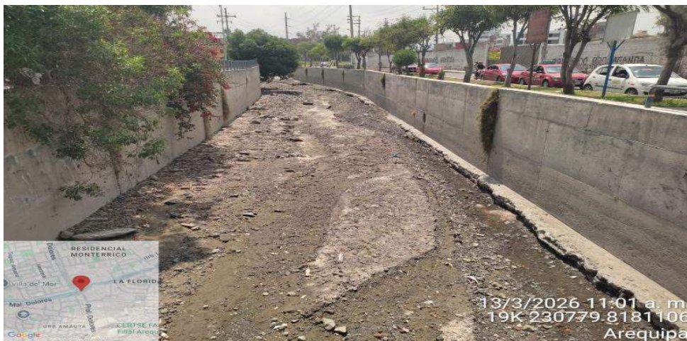
IMAGEN 01: SE OBSERVA EL TRAMO COLMATADO CON VIVNEDAS Y VIAS EN RIESGO EN AMBAS MARGENES DE LA QUEBRADA S/N
